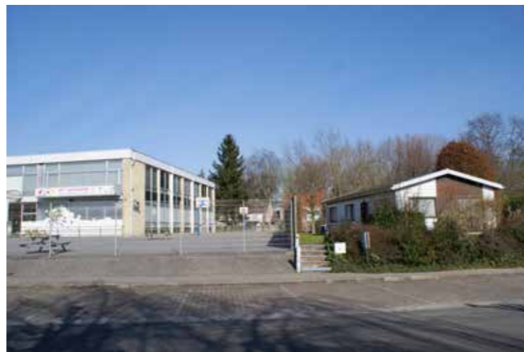
▲ Het gebouw naast basisschool Het Vlinderbos werd intussen gesloopt.
